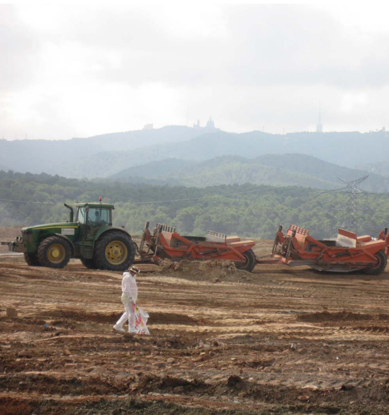
Очистные мероприятия и покрытие асбеста для предотвращения его воздействия в Парке дель Альба (Испания) © Парк дель Альба
