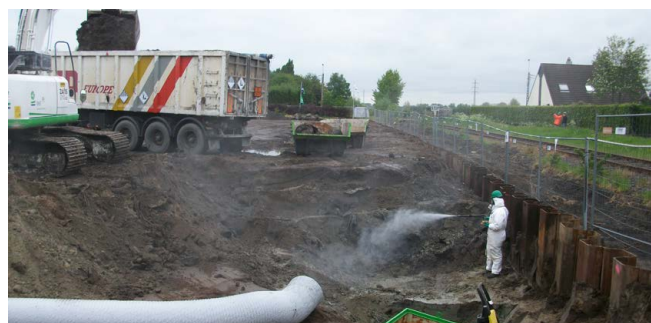
Земляные работы на территории бывшей свалки, Буггенхаут (Бельгия) © Государственное агентство Фландрии по регулированию отходов
