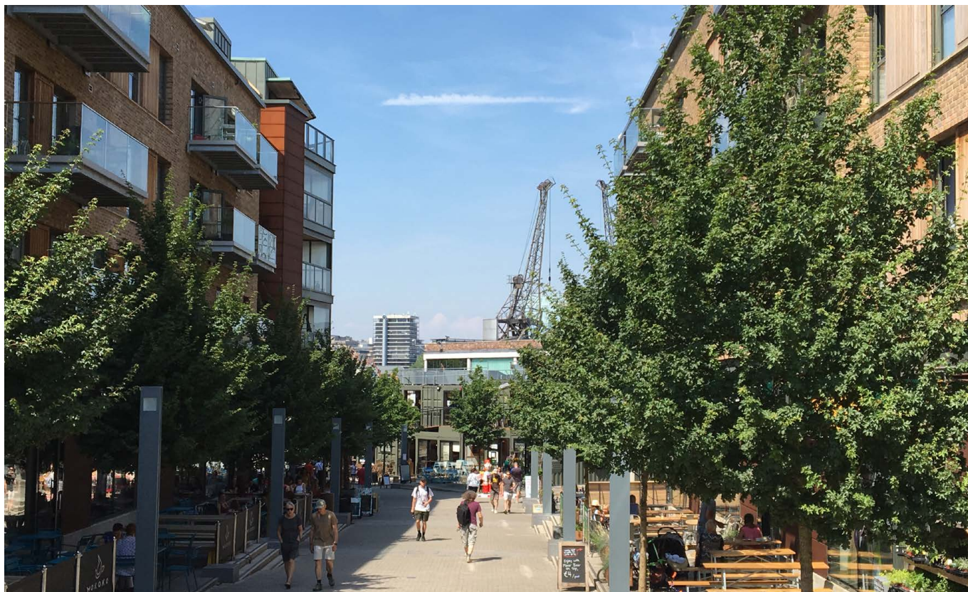
Новая многофункциональная застройка на бывшем промышленном участке в Бристоле (Соединенное Королевство) © Danielle Sinnett
