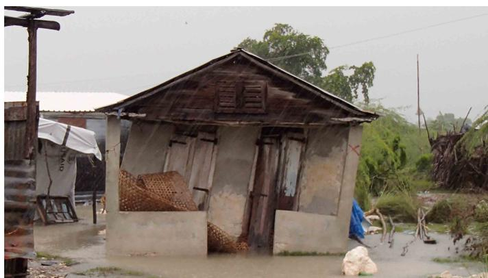
Maisons en parpaings avec structure en béton armé. Le manque d'un savoir faire sur ce type de construction amène à des réalisations qui ne respectent pas les bonnes pratiques de construction et qui n'ont donc pas de bonnes conditions de confort ni un comportement correspondant aux résultats attendus, lors d'une catastrophe naturelle.
