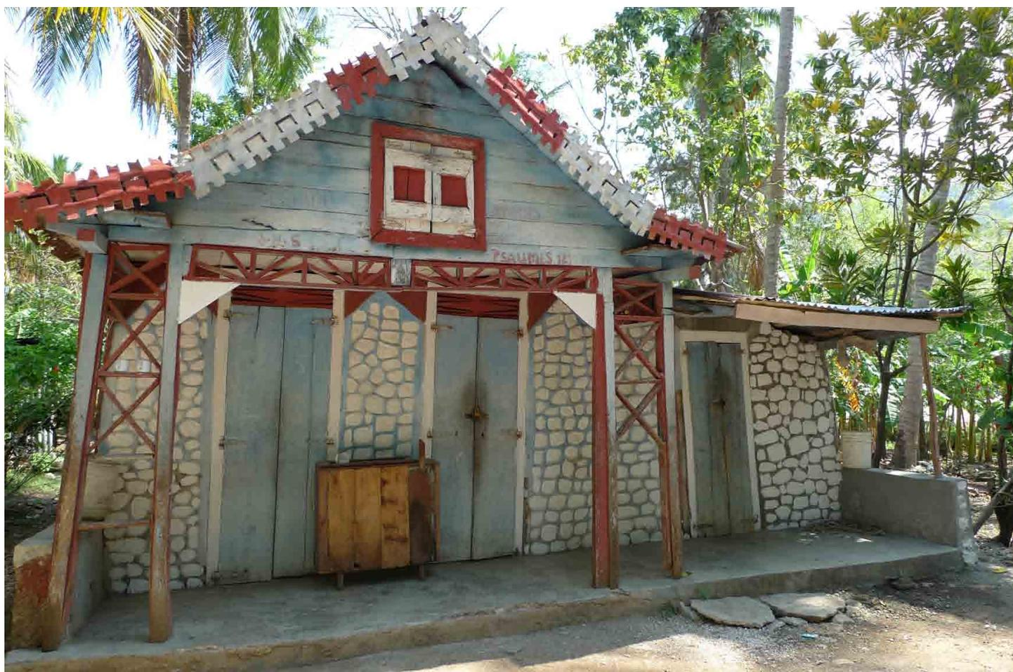
Un bon exemple pouvant servir de référence : maison à Bas Coq Chante (Jacmel) présentant plusieurs éléments de protection face aux catastrophes (contreventement, protection de joints, plateforme de soubassement, galerie, etc.) et tout le confort de la construction traditionnelle.
