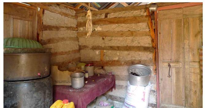
Planches de bois clouées aux poteaux, pour empêcher l'effondrement des panneaux de remplissage des murs vers l'intérieur de la maison, en cas de catastrophe.
