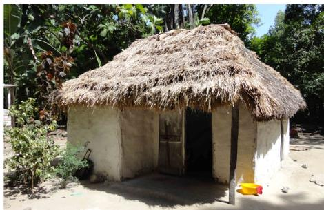
Maison à Jérémie : Poteaux en bois plantés au sol; murs en clissage (*klisay*); toiture à 4 pans en fibres (vétiver); galerie d'angle, toujours du côté opposé à la mer (protection face aux vents).
