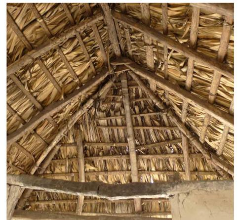
Différents types de toitures en fibres permettant une très bonne ventilation. Existent : en vétiver à 4 pans (gauche); en fibres de palmier à 2 pans (centre); en fibres de palmier à 4 pans (droite).
