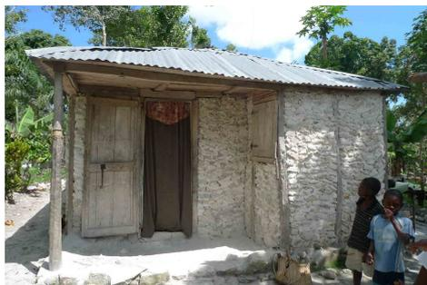
Maison sur une plateforme élevée; soubassement en pierre; structure en bois, remplissage en pierres (*ti wòch*); toiture à 4 pans en CGI, galerie avec plafond de protection face aux vents.
