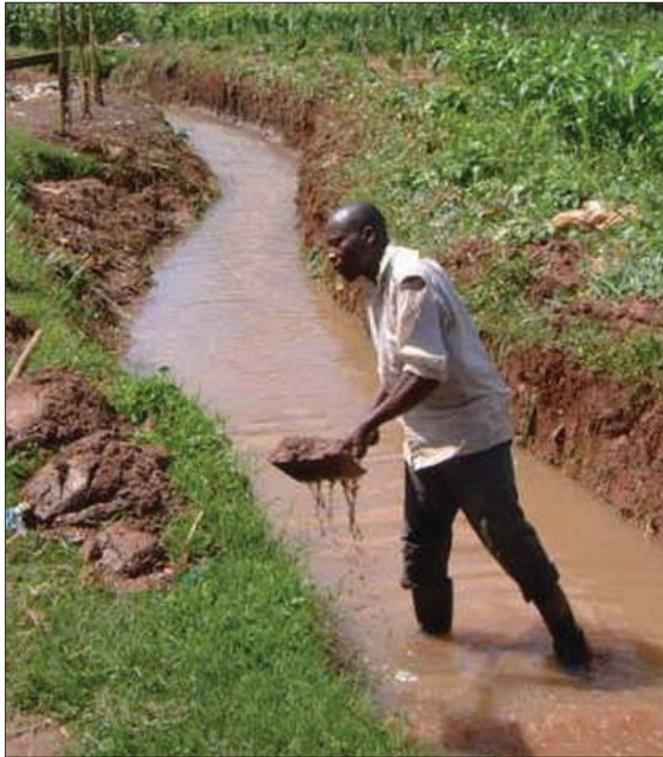
**Figure 26. Gestion environnementale par nettoyage des canaux d'écoulement effectuée afin de réduire les sites de reproduction** (photographie reproduite avec l'aimable autorisation de S. Lindsay)
