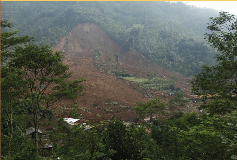
Tanah longsor adalah runtuhnya tanah secara tiba-tiba atau pergerakan tanah atau bebatuan dalam jumlah besar secara tiba-tiba atau berangsur, yang umumnya terjadi di daerah terjal yang tidak stabil. Faktor lain yang mempengaruhi terjadinya longsor adalah lereng yang gundul serta kondisi tanah dan bebatuan yang rapuh.
