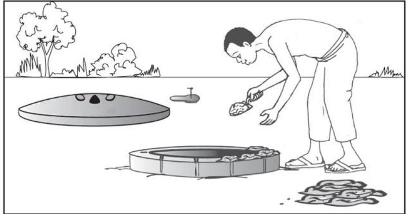
La dalle doit être bien centrée et bien assise sur le soubassement.
